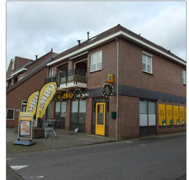
Omvang supermarkten Moergestel te klein
